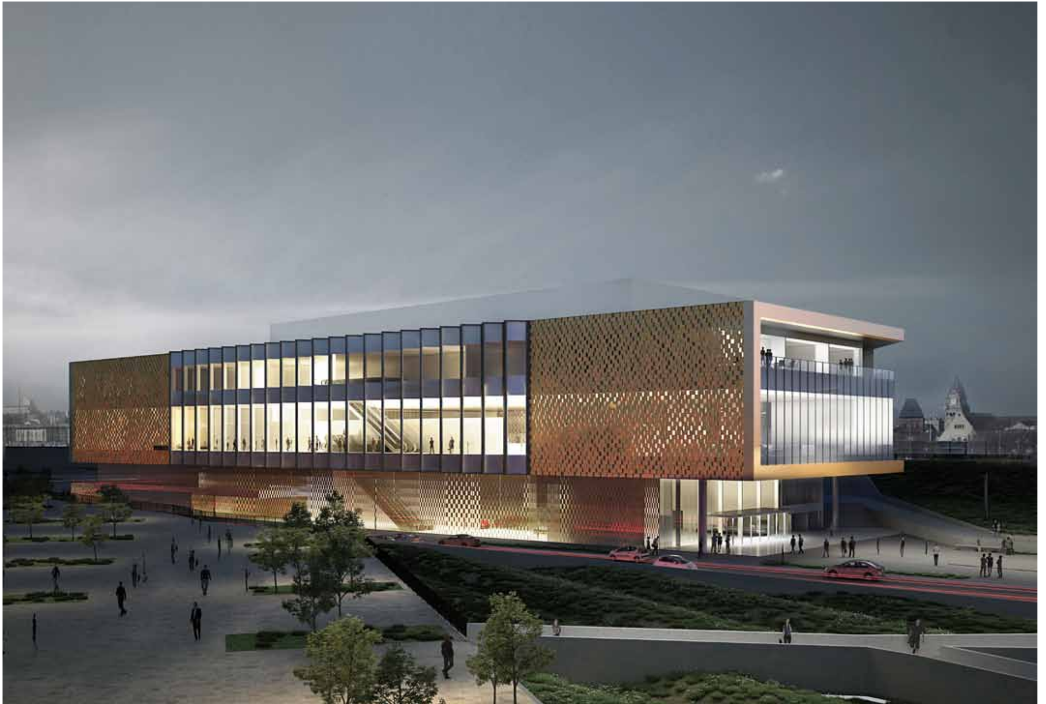
Vue Est du bâtiment
